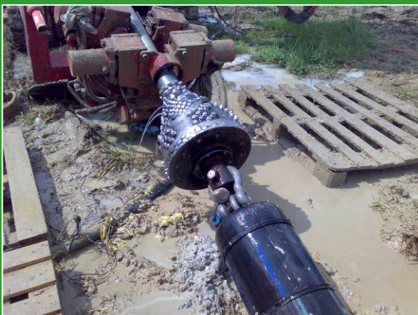
Fase di tiro tubazione con sonda E.G.T. 2022 17 Ton
