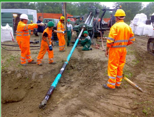
Inizio perforazione con mud-motor attraversamento Fiume Tanaro 750 m in marna calcarea
