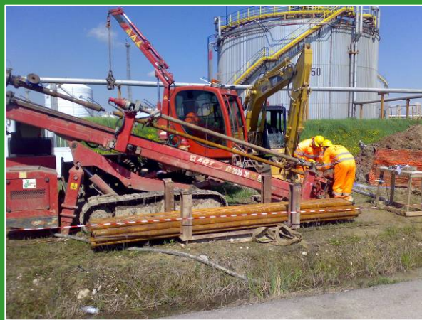
Posa tubazioni drenanti con sonda EGT 2035 35 Ton
